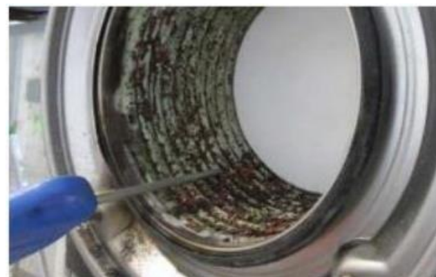
4. Suflați spațiile dintre serpentinele schimbătorului de căldură cu aer la presiune ridicată.
